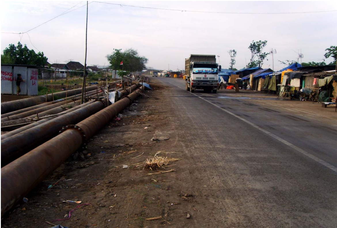
Gambar 61. Situasi pengungsi warga Besuki Timur yang menempati sepanjang jalan Tol, sehingga mengganggu upaya pasokan sirtu dan pengaliran lupsi ke Kali Porong melalui pipa-pipa. Sebelumnya pengungsi menempati dua sisi jalan tol.
