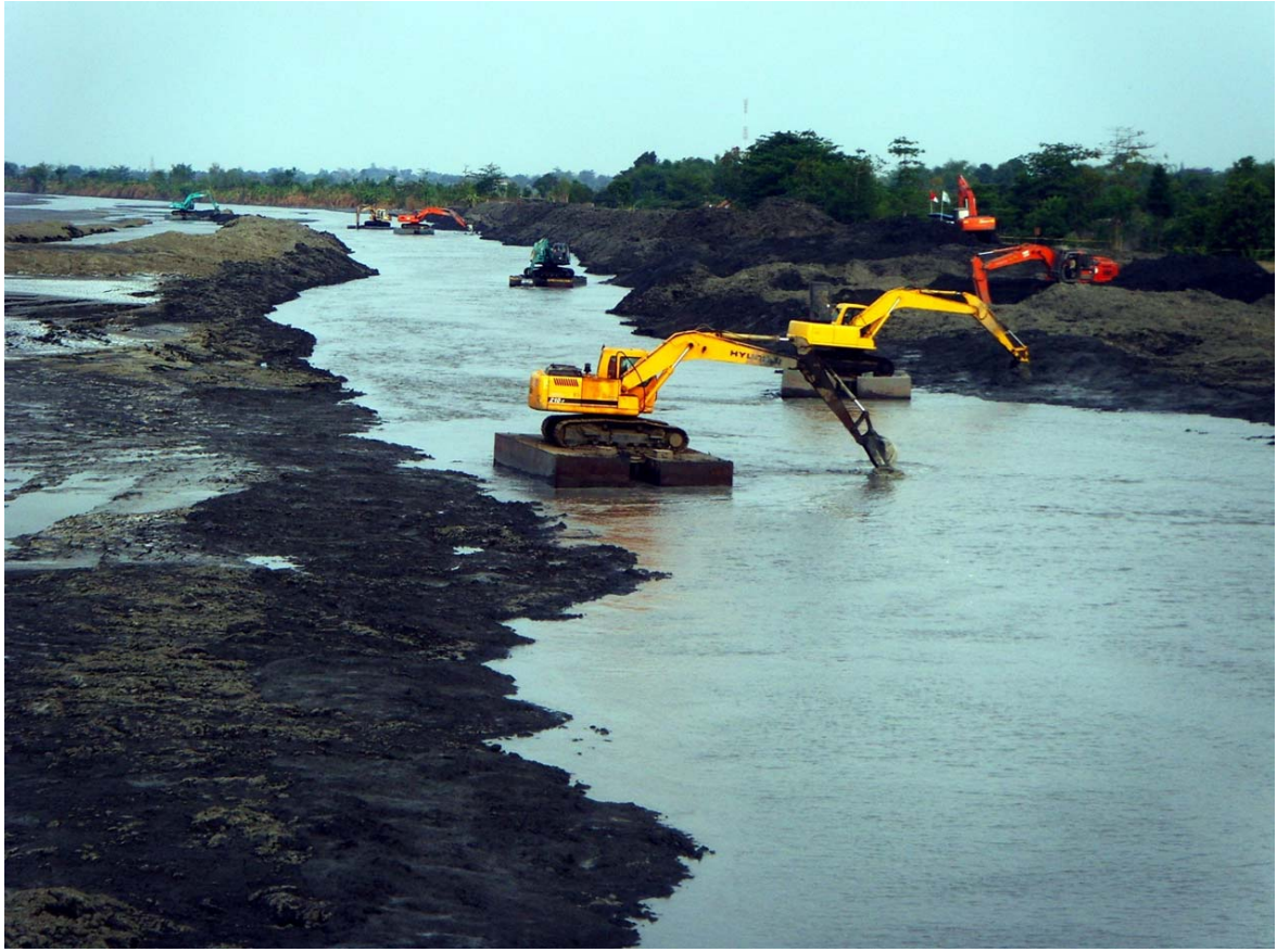
Gambar 50. Kegiatan agitasi menggunakan alat berat, agar bila saatnya aliran Kali Porong sudah cukup besar, sedimen Lupsi yang telah mengendap dapat dierosi ( wash out ) dan dihanyutkan ke hilir.
