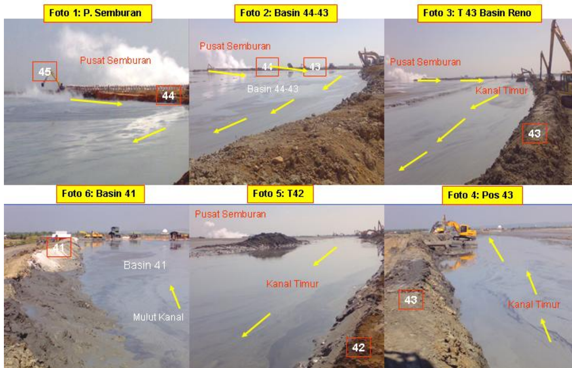
Gambar 54. Foto memperlihatkan sistem pengaliran dari Pusat Semburan melalui Kanal Timur menuju Basin 41. Sebagai implikasi runtuhnya Pusat Semburan dan berubah menjadi Kaldera (2 Juni 2008), mulai saat itulah pengaliran yang konvensional melalui jalur barat (Kanal Barat).
