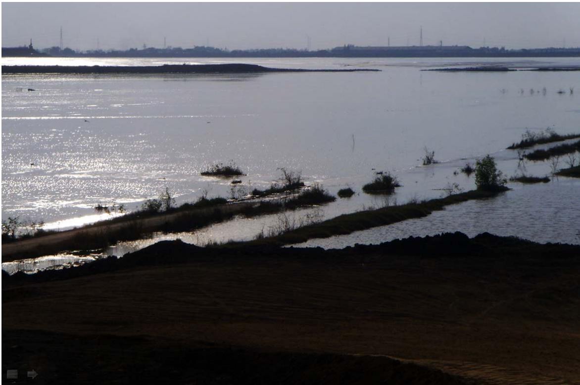
Gambar 47. Memperlihatkan jebolan tanggul dalam Reno (P 611) sehingga Lupsi telah menggenangi Basin Reno, yang sebelumnya diisi dengan air. Celah Reno merupakan suatu titik lemah yang berpotensi menimbulkan bencana meluapnya PAT. Karena itu BPLS berupaya sekuat tenaga sebelum musim hujan, Tanggul Baru Reno (Lingkar luar) dapat dibangun.
