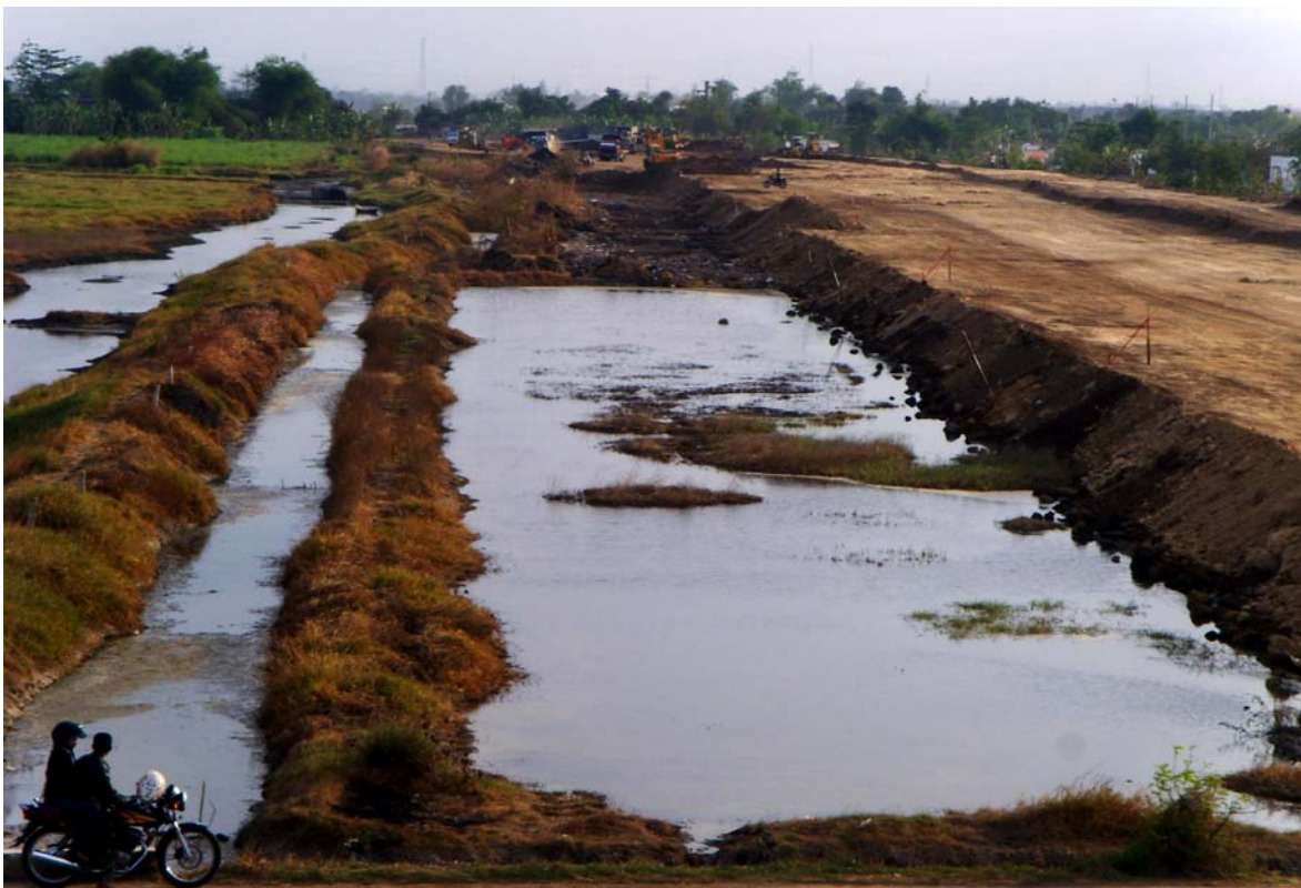
Gambar 46. Pembuatan Tanggul Lingkar Luar di Desa Renokenongo, untuk mencegah Lupsi tidak meluap ke timur, karena Tanggul Lingkar Dalam telah Jebol.
