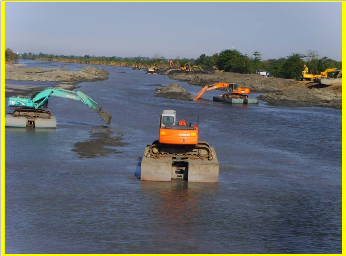
Gambar 20. Kondisi Kali Porong di sisi timur Jembatan, memperlihatkan alat berat melakukan normalisasi dengan agitasi (mengaduk-aduk), sambil menunggu gelontoran dari hulu (Foto Prasetyo Oktober 2008).
