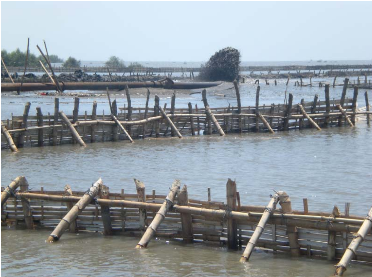
Gambar 5. Pengerukan dan reklamasi di Muara Kali Porong bukan lagi sebagai impian. Gambar memperlihatkan pengisian daratan baru (reklamasi) dari bagian seluas 26 hektar yang direncanakan, sebagai salah satu subsistem misi normalisasi Kali Porong (Sumber Prasetyo 2008).
