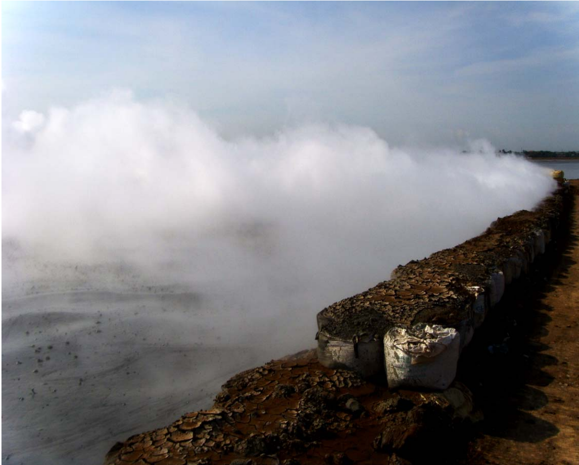
Gambar 8. Memperlihatkan saat kondisi terkini semburan Lupsi yang masih dahsyat, dengan kick tinggi, gelombang besar, tanggul cincin bergoyang diliputi asap tebal. Pada situasi tersebut para pekerja mengamankan diri dan berdoa semoga tanggul cincin tetap tahan tidak jebol seketika, daripada yang umum terjadi overtopping dari jajaran sandbag (Foto Prasetyo, Oktober 2008).
